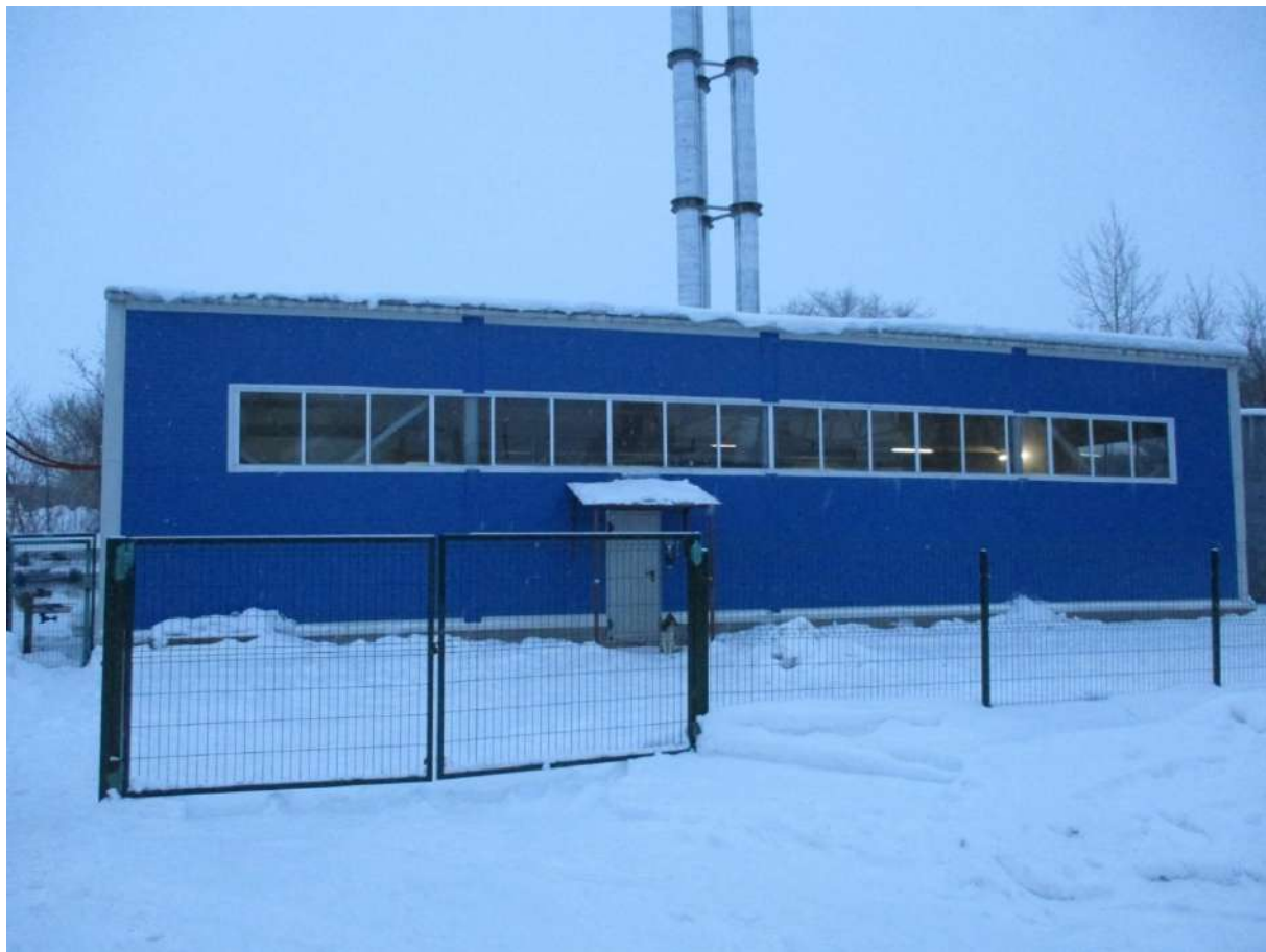
Рисунок 1.2.124 - Общий вид территории котельной №24М
