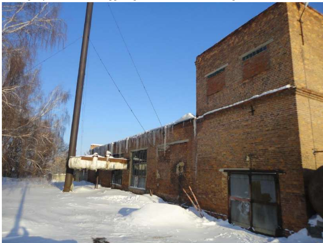
Рисунок 1.2.147 - Общий вид территории котельной № 28
