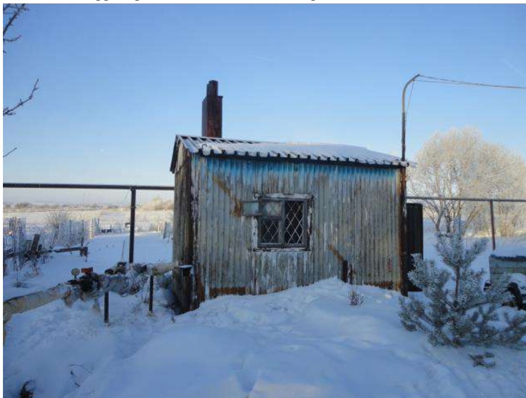
Рисунок 1.2.113 - Общий вид котельной 20а 2эт дом д. Шишлово.
