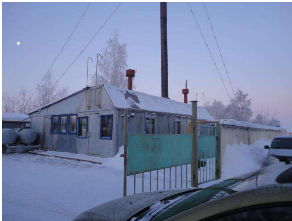
Рисунок 1.2.110 - Общий вид котельной 20М п. Ширинский.
