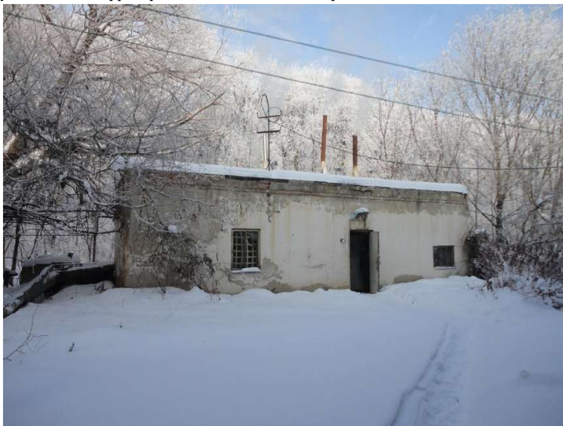
Рисунок 1.2.144 - Общий вид котельной 26а
