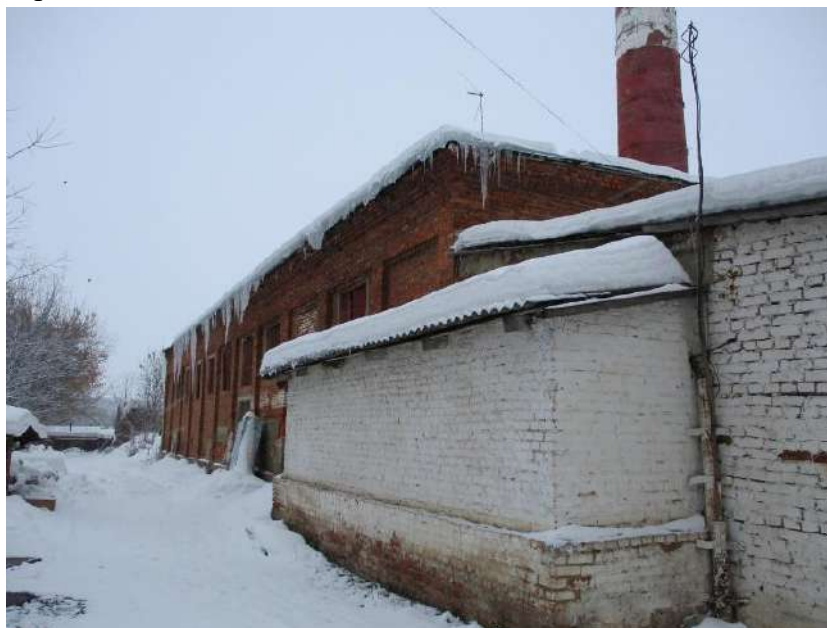
Рисунок 1.2.129 - Общий вид территории котельной № 25
