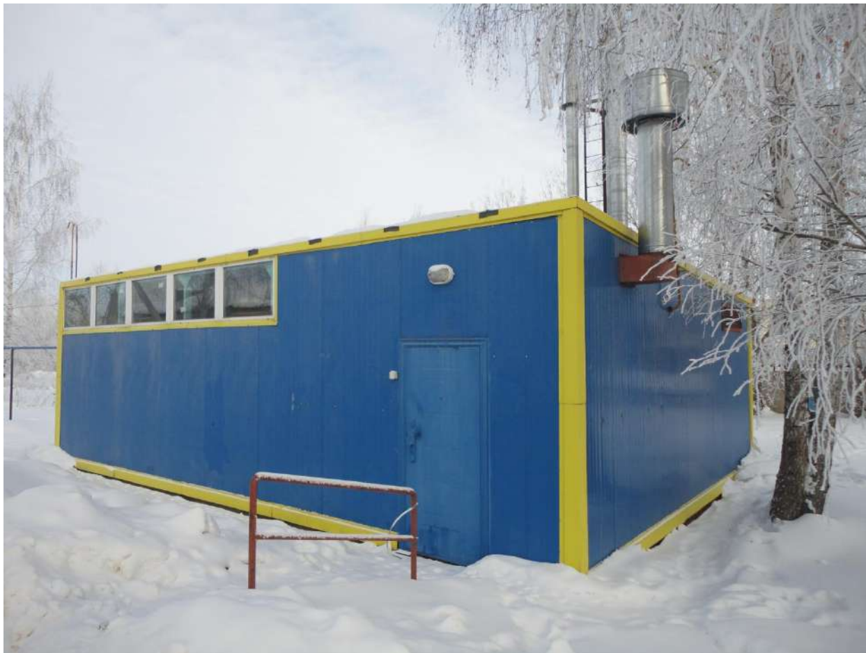
Рисунок 1.2.138 - Общий вид территории котельной № 26
