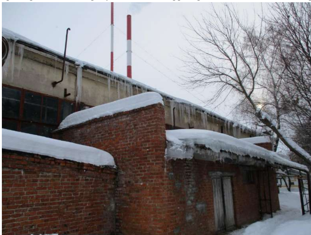
Рисунок 1.2.152 - Общий вид территории котельной Спасское
