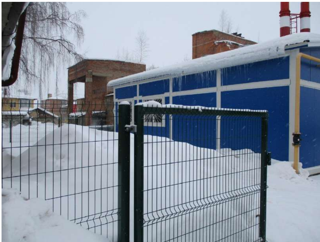
Рисунок 1.2.119 - Общий вид территории котельной № 23м
