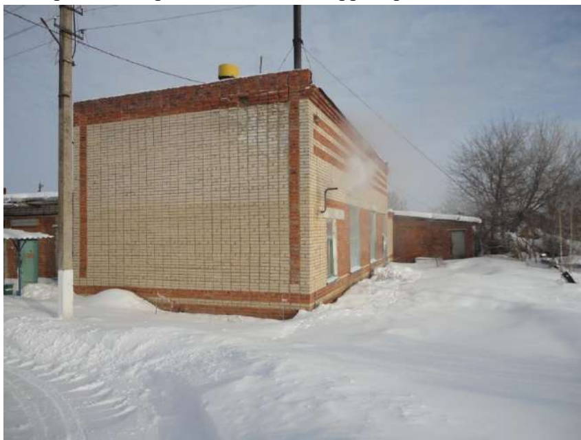
Рисунок 1.2.145 - Общий вид территории котельной № 27
