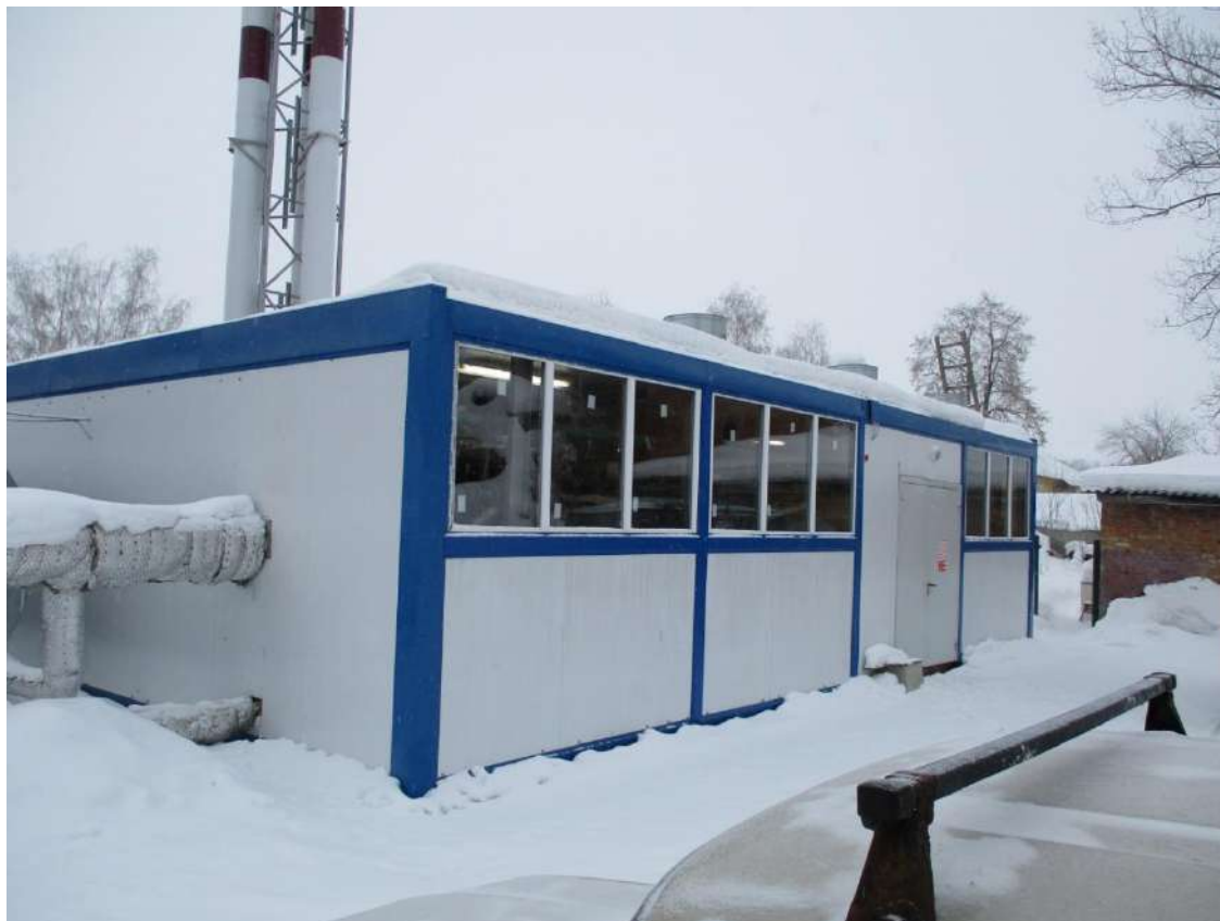
Рисунок 1.2.115 - Общий вид территории котельной № 21м
