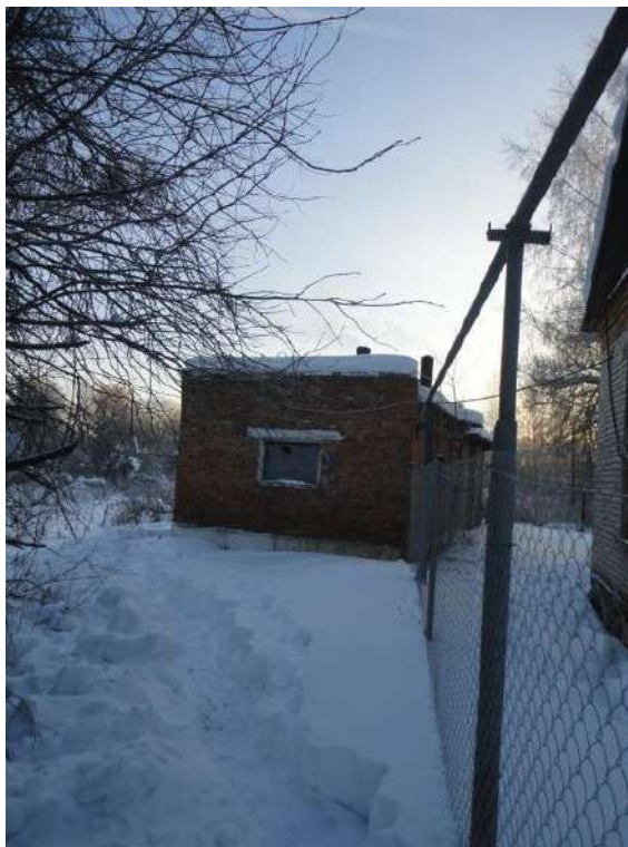
Рисунок 1.2.114 - Общий вид котельной 20в, д. Озерки.
