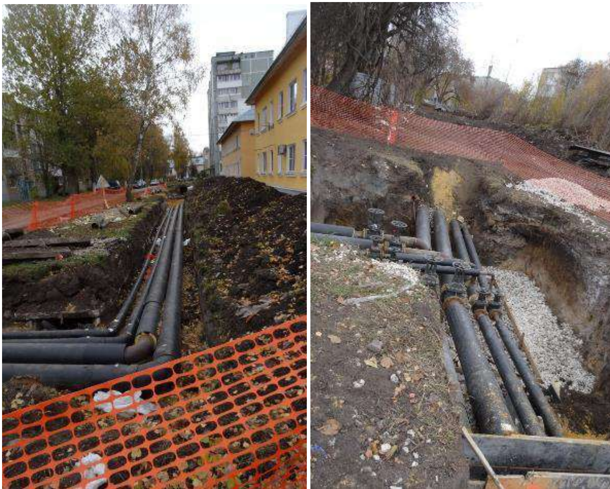
Рисунок 1.2.38 - Реконструкция участков тепловых сетей отопления и ГВС от котельной №10М
