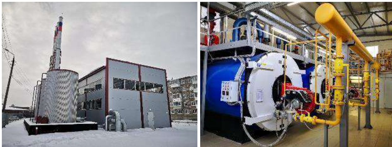
Рисунок 1.2.38 - Общий вид котельной №2М и котельного зала
