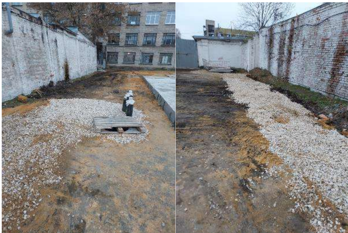
Рисунок 1.2.38 - Строительство участков тепловых сетей ГВС от котельной №7М
