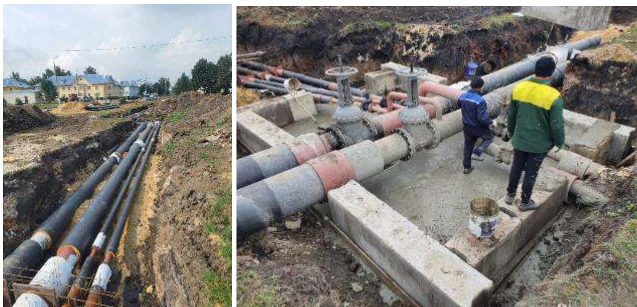
Рисунок 1.2.38 – Реконструкция тепловых сетей от ТК-38 до ТК-45
