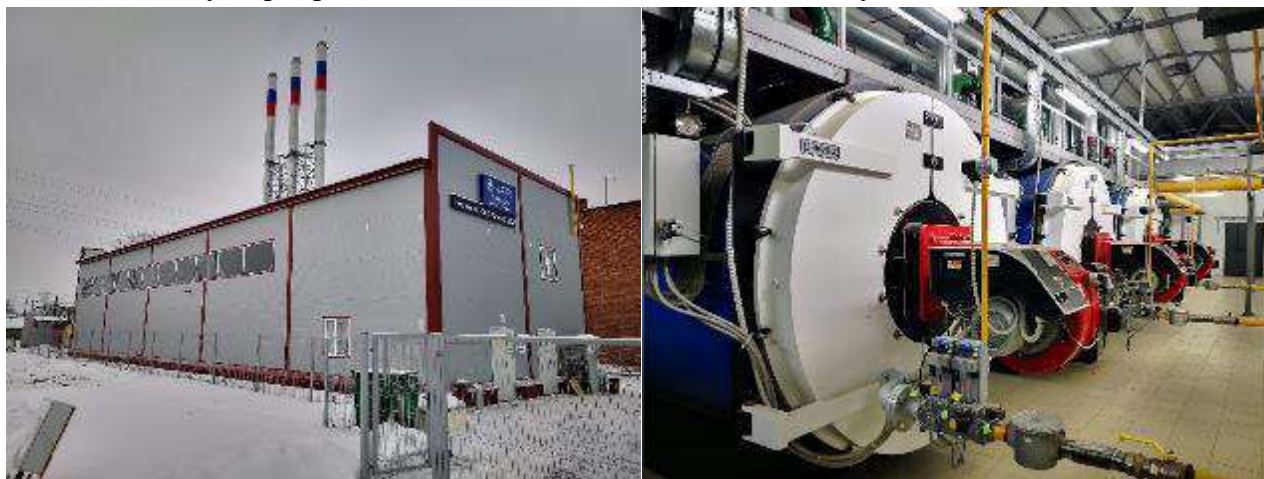
Рисунок 1.2.38 - Общий вид котельной №34М и котельного зала
