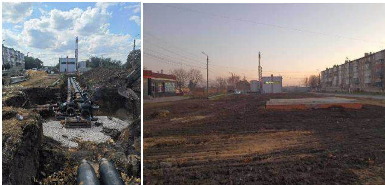
Рисунок 1.2.38 – Тепловые сети от котельной №2М
