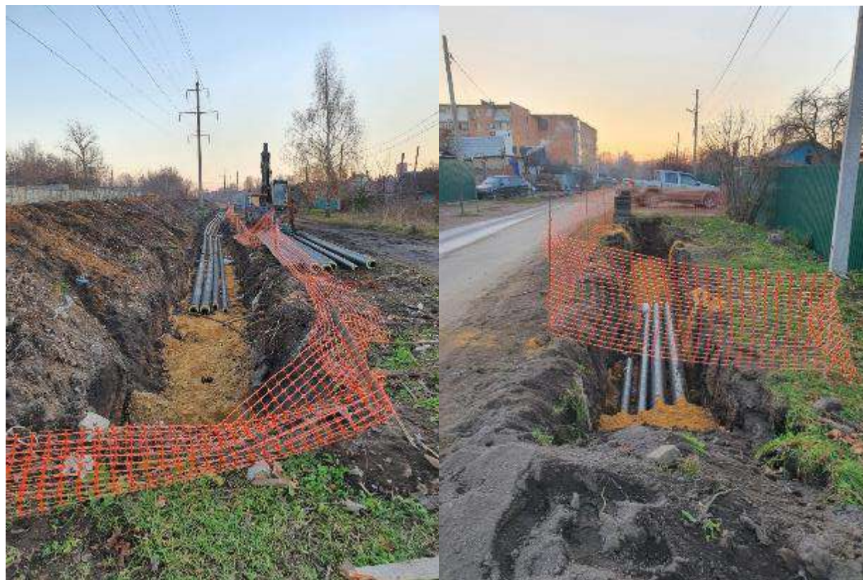
Рисунок 1.2.38 – Строительство участков тепловых сетей от котельной Депо
