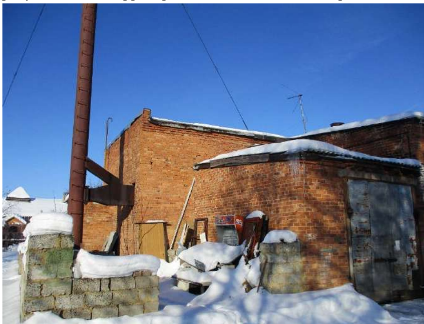
Рисунок 1.2.22 - Общий вид котельной №4 расположена г. Новомосковск, Вахрушева, 34Б.
