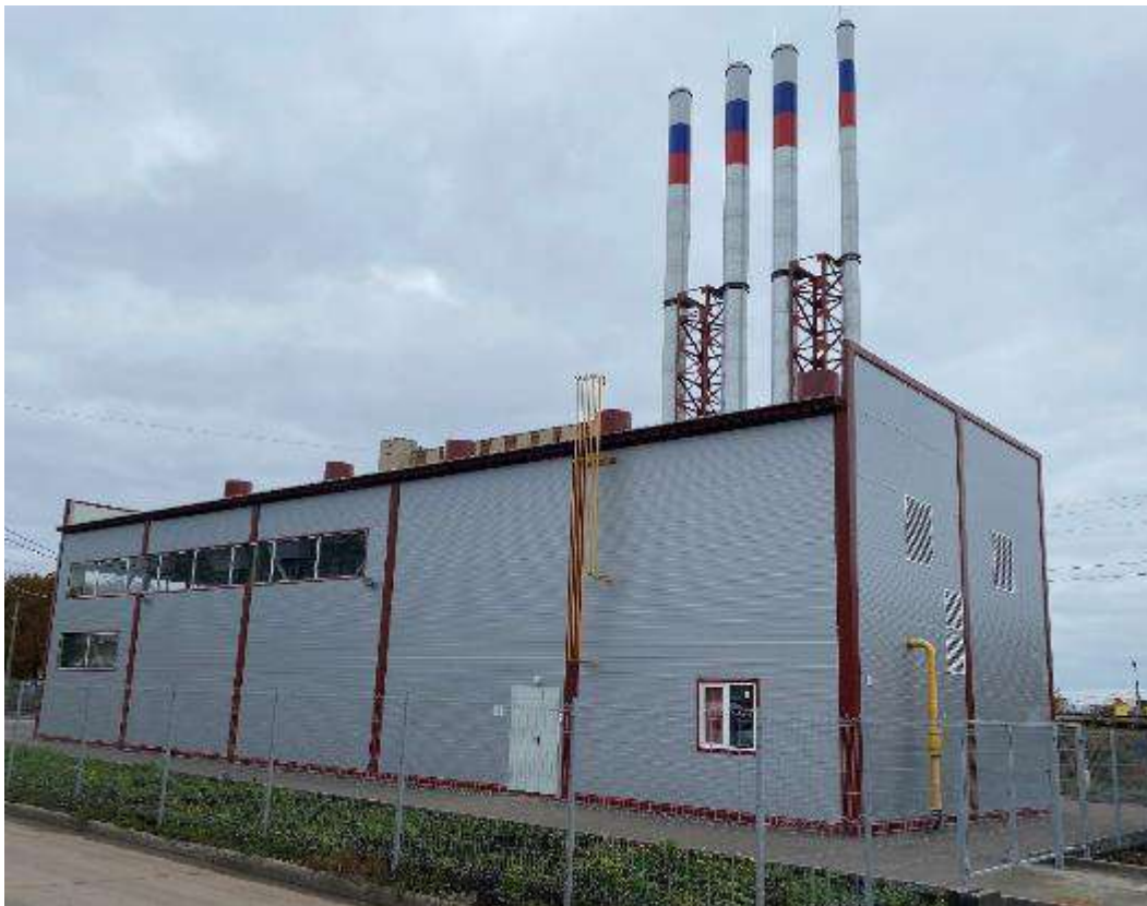
Рисунок 1.2.15 – Общий вид источника тепловой энергии – Котельная №2М
