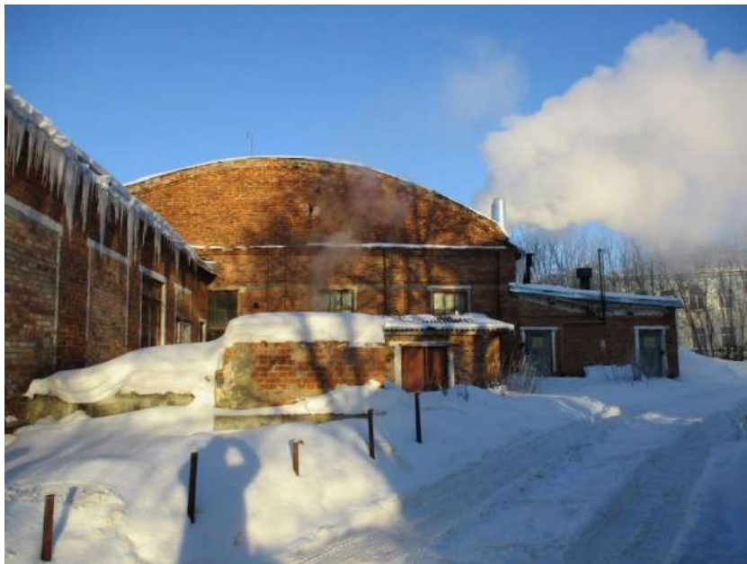
Рисунок 1.2.38 - Общий вид территории котельной №10
