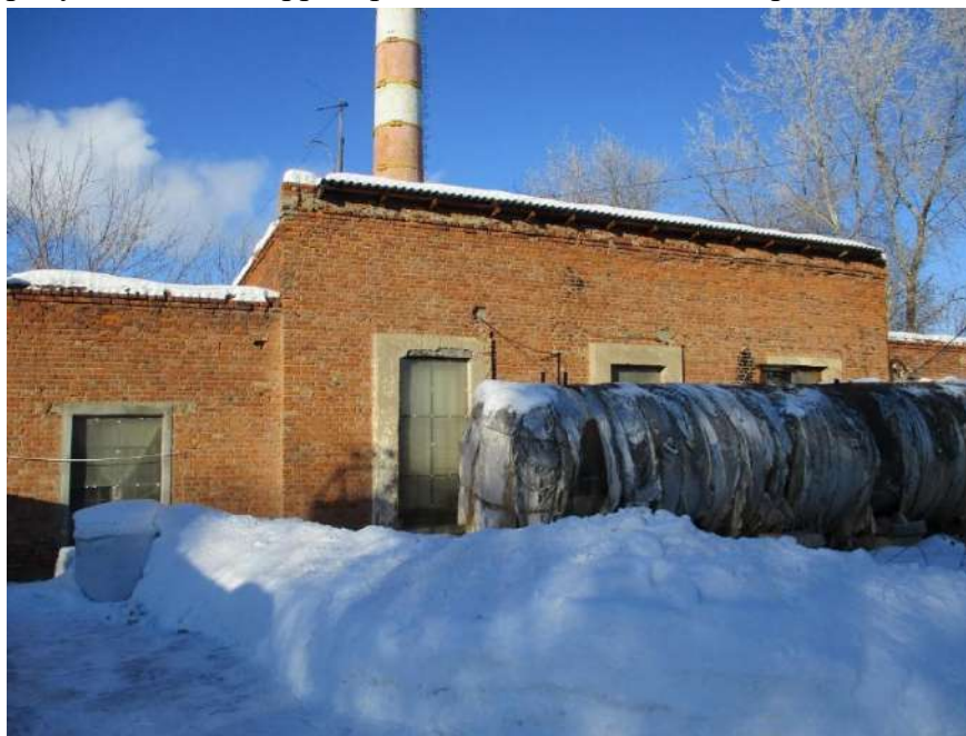
Рисунок 1.2.25 - Общий вид котельной №5 расположена г. Новомосковск, Аварийная, 19А.
