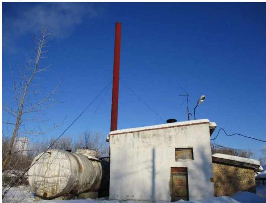
Рисунок 1.2.73 - Общий вид котельной 16, расположена г. Новомосковск, Белинского 34а.
