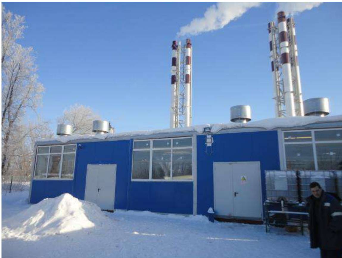
Рисунок 1.2.87 - Общий вид территории котельной №19з
