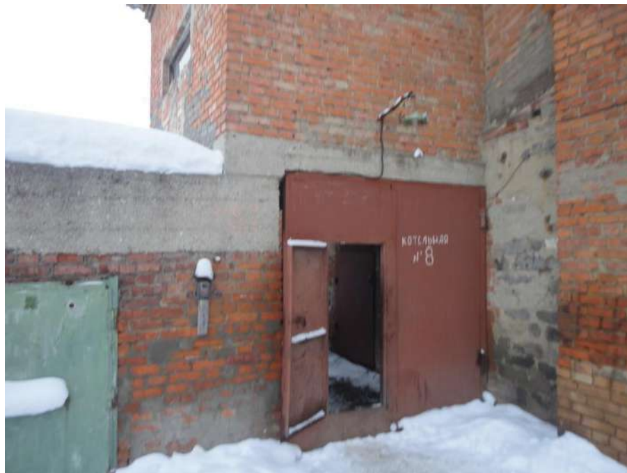
Рисунок 1.2.30 - Общий вид котельной №8
