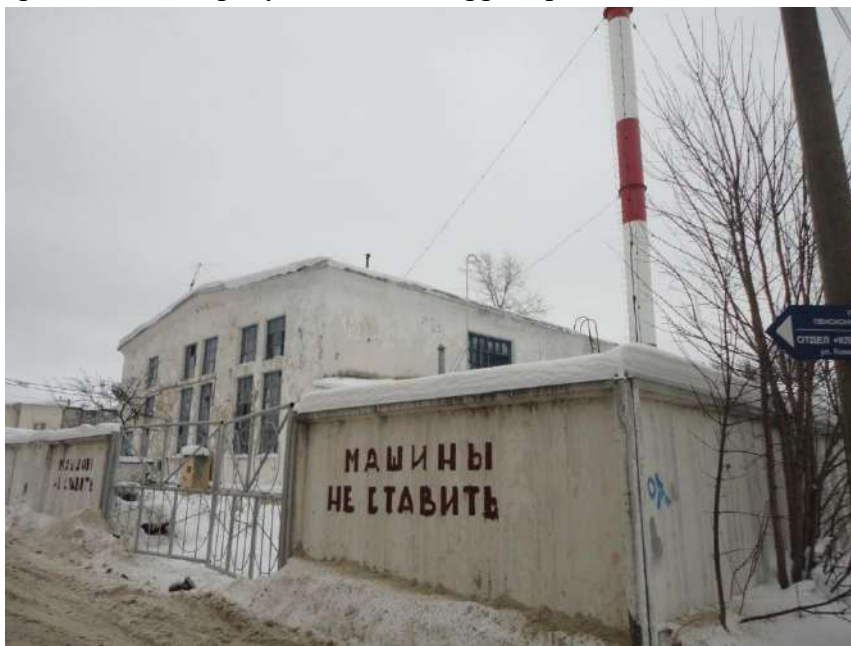
Рисунок 1.2.51 - Общий вид территории котельной №13
