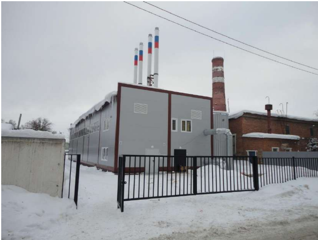
Рисунок 1.2.77 - Общий вид территории котельной №17М
