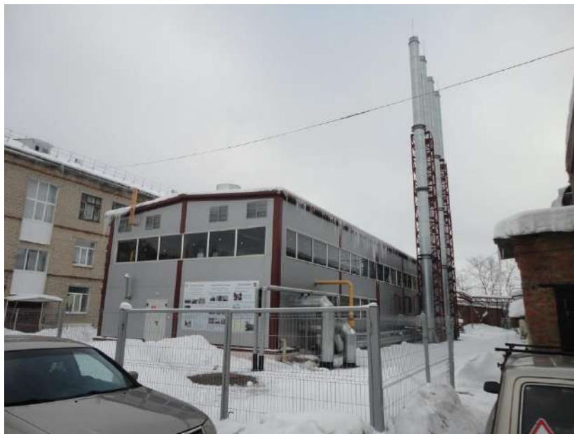
Рисунок 1.2.93 - Общий вид территории котельной №31М
