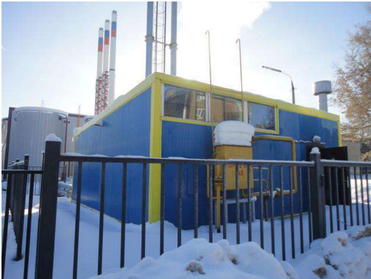
Рисунок 1.2.98 - Общий вид территории котельной № 32М
