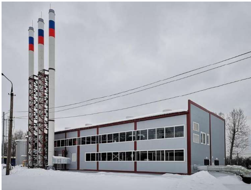
Рисунок 1.2.45 - Общий вид котельной 12м
